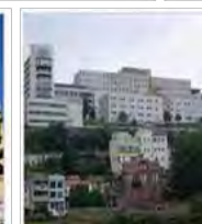
Hospital Juan Canalejo La Coruña
