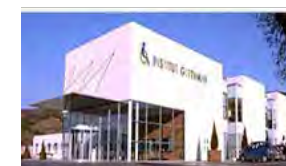
Institut Guttmann Barcelona
