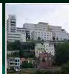
Hospital Juan Canalejo La Coruña
