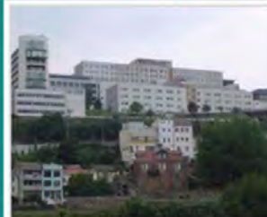
Hospital Juan Canalejo La Coruña
