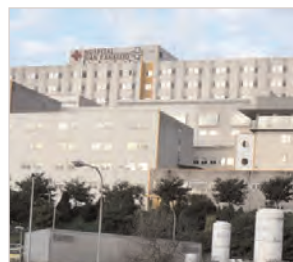
Hospital Juan Canalejo La Coruña
